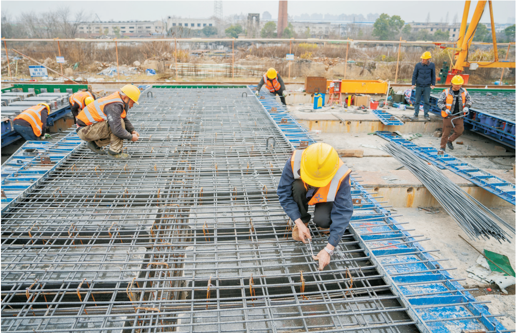
2月6日,湘潭市下摄口大桥项目工地,工人在预制桥面板。目前,该项目施工人员陆续返岗,各施工点位也开始忙碌起来,全力以赴推进项目建设,确保6月30日前建成通车。 湖南日报全媒体记者 李健 摄
