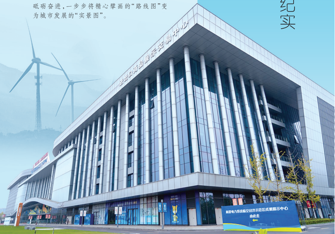
湖南新型电力系统临空经济示范区建成投运。
