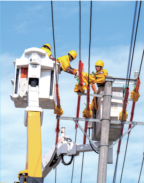
开展高空带电作业,市民“无感”用电。
