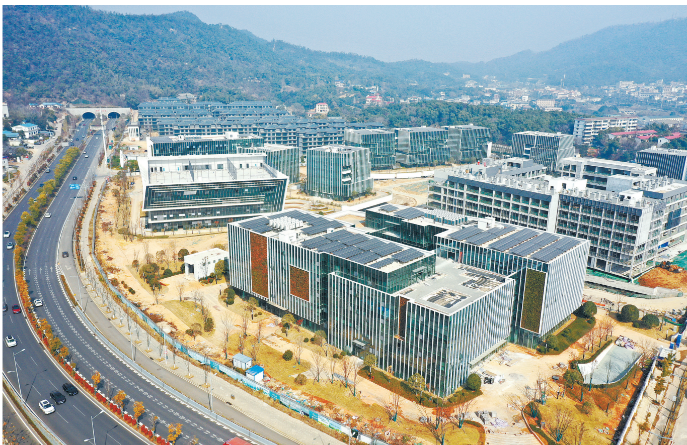
1月20日,位于湖南湘江新区的湘江创智园项目产业楼精装修已基本完成,预计上半年投入使用。该项目总用地面积约105亩,总建筑面积约19万平方米,共规划18栋单体建筑。重点面向新材料技术及应用,人工智能、大数据核心装备及系统,生物技术及应用三大产业方向,将打造校企联合研发平台、孵化器(众创空间)、成熟企业总部等多种楼宇形态。
