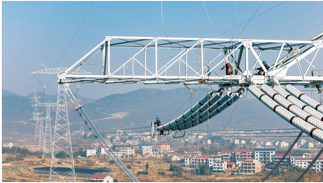
1月6日，位于涟源县斗笠山镇境内的“宁电入湘”工程，工作人员在高空作业。3日，宁夏-湖南±800千伏特高压直流输电工程(“宁电入湘”)娄底段全线贯通，途经涟源县、娄星区、双峰县，线路长度为103.66千米，新建铁塔235基。 吴永华 摄(湖南图片库)
