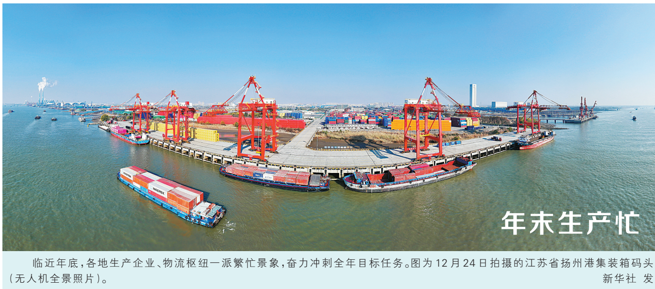
临近年底，各地生产企业、物流枢纽一派繁忙景象，奋力冲刺全年目标任务。图为12月24日拍摄的江苏省扬州港集装箱码头（无人机全景照片）。新华社发
