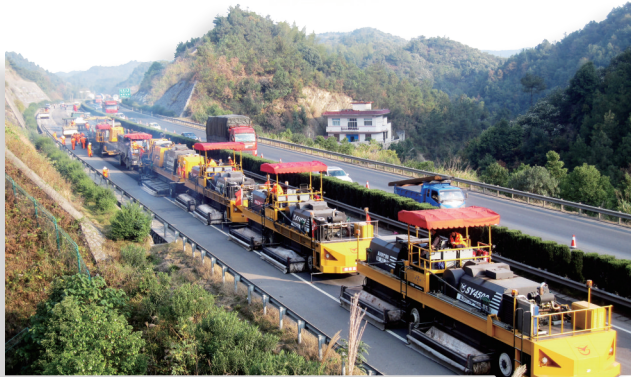
▲ 潭邵高速公路沥青路面就地热再生工程施工现场。
