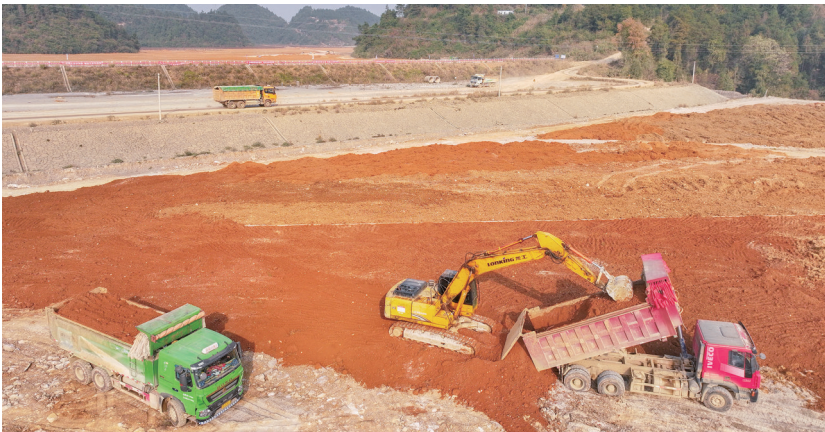
12月19日，花垣县猫儿乡洞尾尾矿库，中铁城建集团的工人正在进行覆土覆绿工程施工。近年来，该县加快推进矿业环境综合治理与生态修复，通过实施一系列科学有效的措施，对受损的矿山生态环境进行系统修复，让昔日矿山重披绿装。
