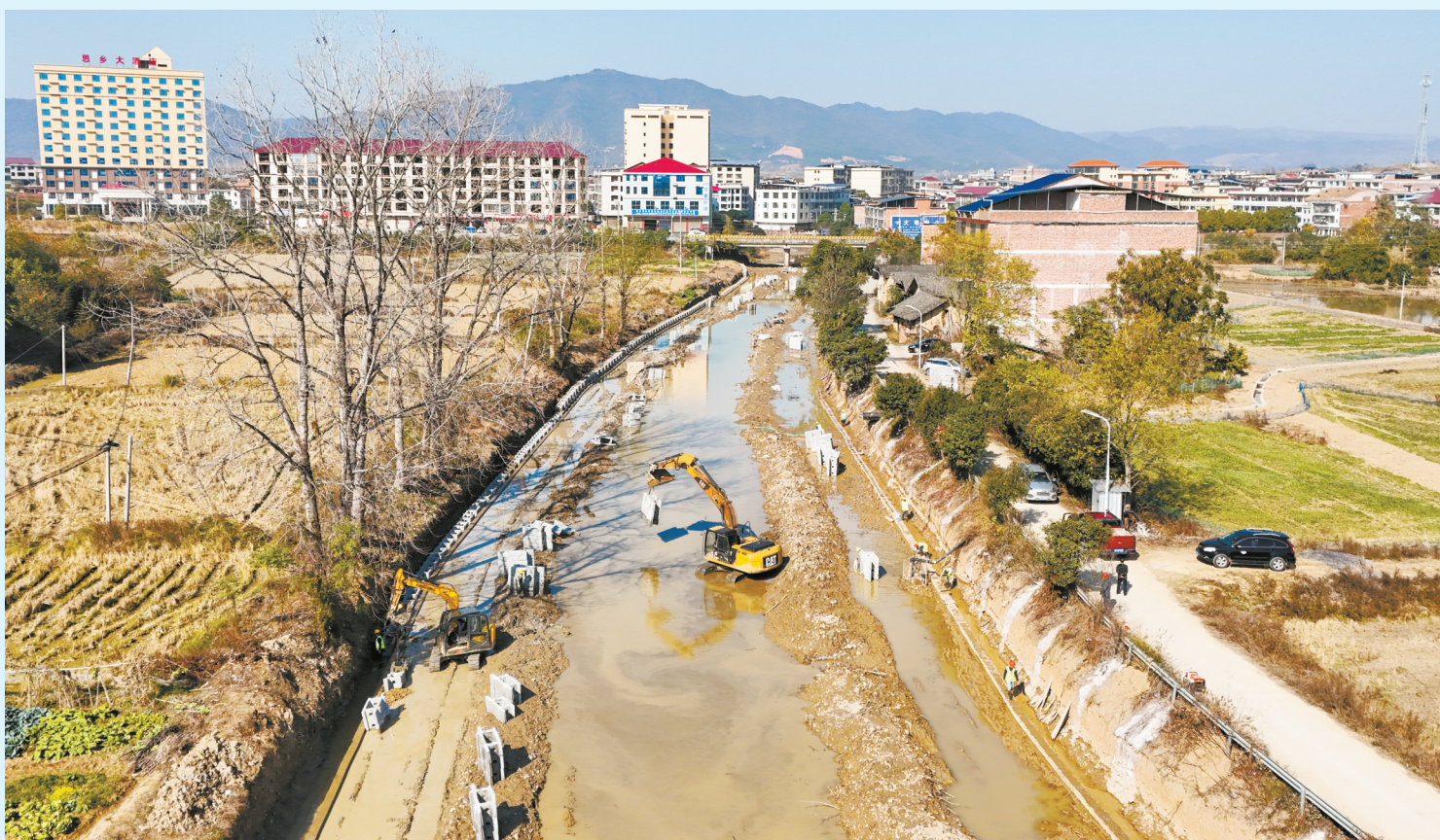
12月16日,祁东县国债水利项目祁水河治理工程蒋家桥镇新江社区段施工现场,工人正在吊运仿石生态砖,护砌挡墙,加固河岸。 陈延上 摄 (湖南图片库)
