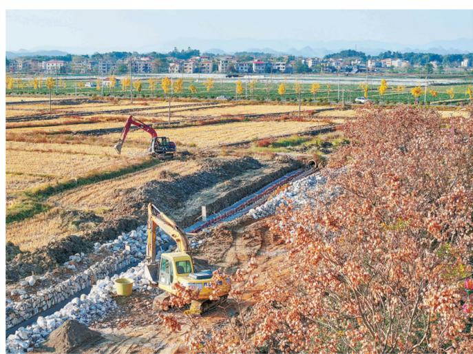
12月14日,道县清塘镇楼田村,施工人员在高标准农田建设现场施工。时下,该县加紧推进高标准农田建设,通过平整土地、改造田块、修建机耕道和水渠等,改善农田灌溉及耕种条件,促进机械化、规模化经营,为来年粮食增产、农民增收打好基础。
