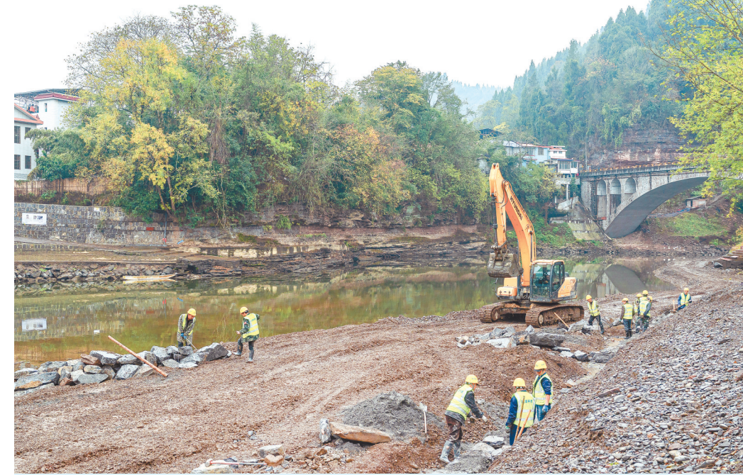
12月10日,吉首市河溪镇张排村河道综合治理施工现场,工人正在忙碌作业。该村地处峒河与万溶江交汇处。今年,当地加大河流综合治理力度,通过疏浚河道、绿化岸坡等措施,畅通河流水系、提升防洪能力、改善人居环境。 梁永鸿 摄(湖南图片库)
