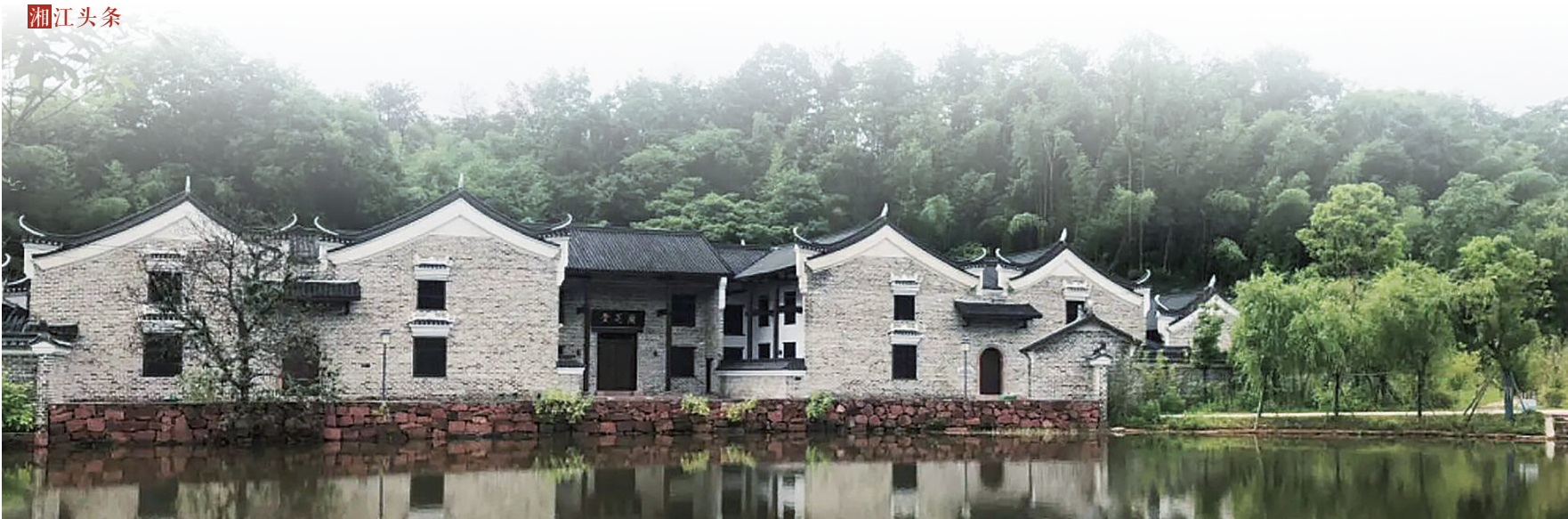
衡阳县人民政府近年修建的琼瑶祖屋兰芝堂。
