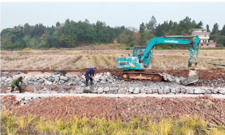
12月3日，工人在常宁市洋泉镇东塘村田间排水渠建设现场施工。入冬以来，该市抢抓冬季枯水期有利时机，扎实推进水利工程建设。 周秀鱼 摄 (湖南图片库)
