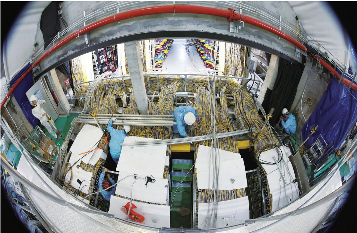
我国大科学装置——江门中微子实验的探测器主体日前建成。江门中微子实验位于广东江门开平市,将以测量中微子质量顺序为首要科学目标,同时开展多项重大前沿交叉研究。图为11月23日,工作人员在实验大厅布置电子学线缆。新华社发
