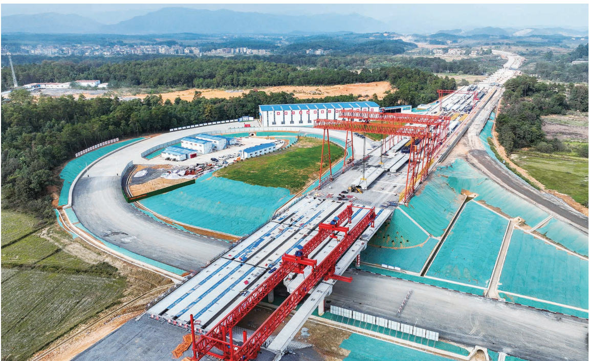
11月24日,道县寿雁镇,零(陵)道(县)高速道县西互通箱梁施工现场,工人正在进行箱梁架设作业。该项目北接永零高速,南至厦蓉高速。建成后,将极大地改善湘南山区交通状况,推动沿线经济高质量发展。 蒋克青 摄(湖南图片库)
