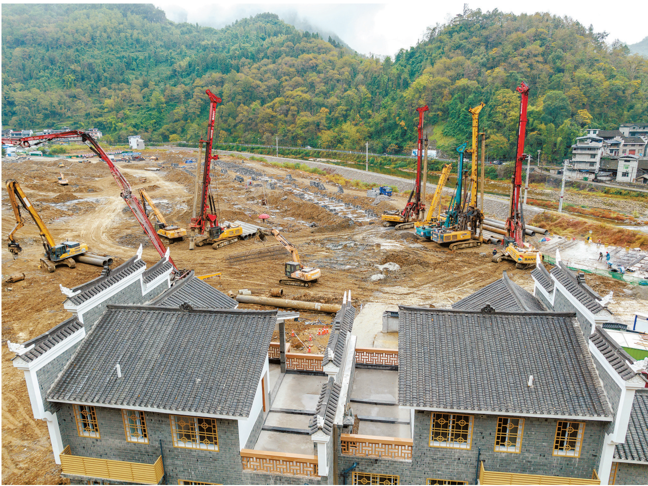
11月17日，吉首市矮寨镇大兴水库工程矮寨移民安置区建设现场，工人在加紧施工。连日来，参建单位抢进度、抓质量、保工期，全力推进基础设施及安置房项目建设。
