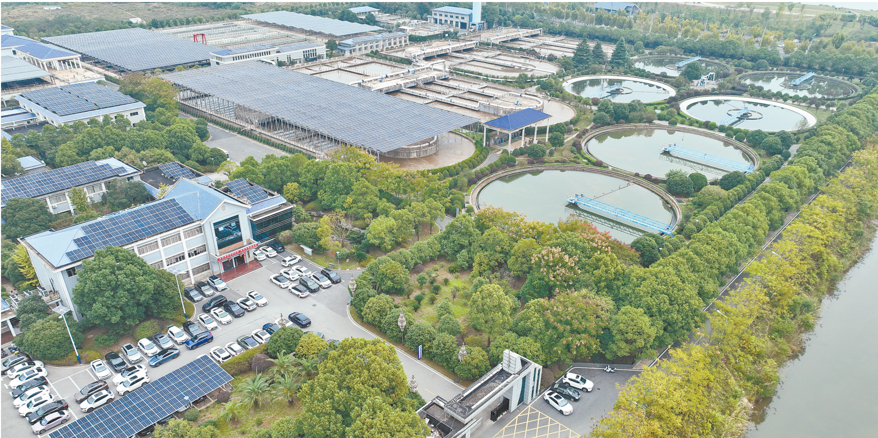
湘潭市河西污水处理厂“光伏+水务”项目，总装机容量3.07兆瓦。
