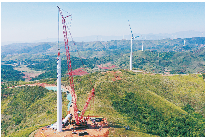
11月6日,桂阳县洋市风电场,施工人员在吊装风力发电机组设备。近年来,该县充分利用高山风力资源优势,大力发展风电产业,推动清洁能源建设,促进当地经济发展。
