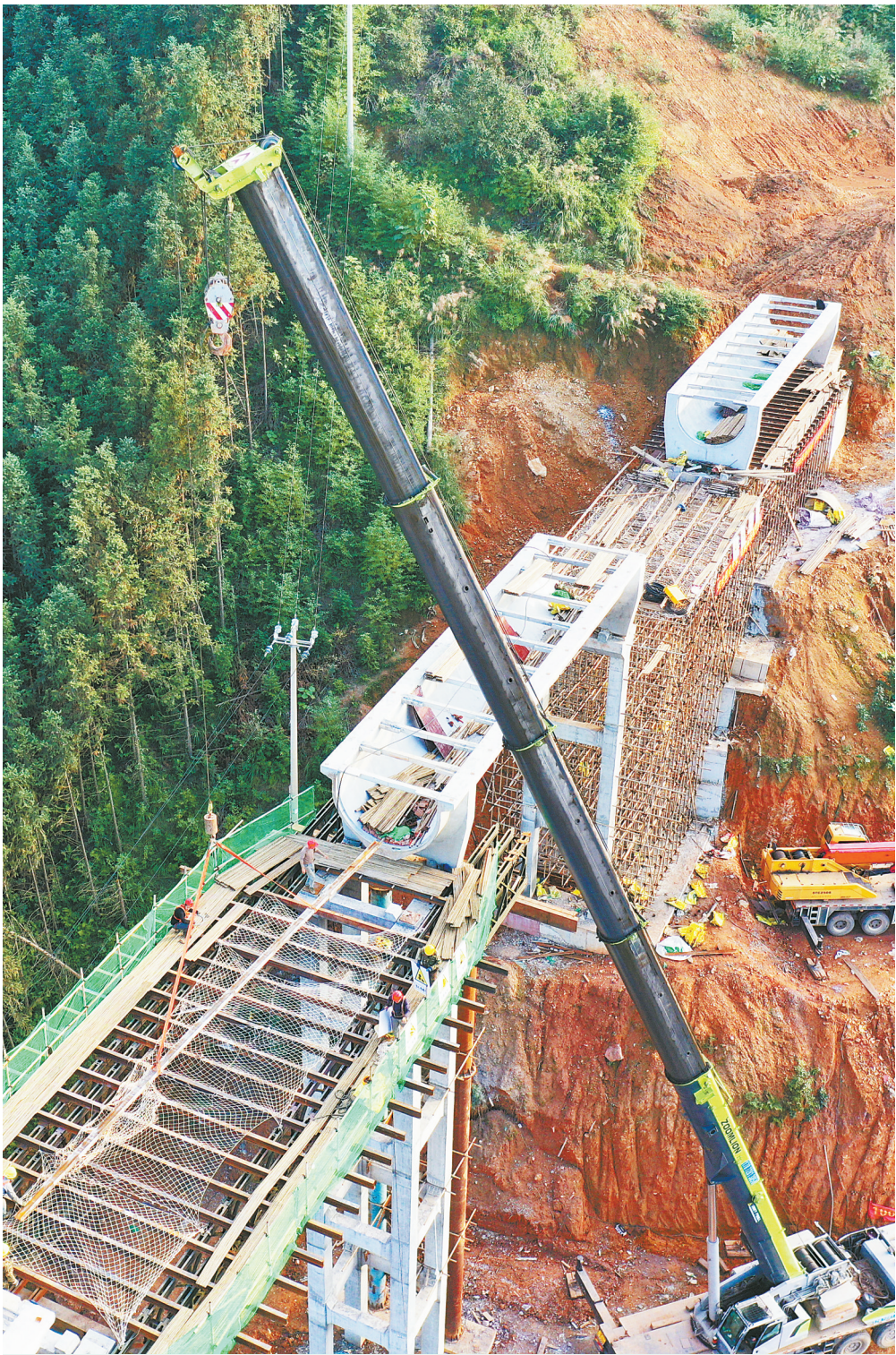
10月30日,蓝山县毛俊水库田心渡槽项目建设工地,工人在忙碌施工。湖南毛俊水库工程是“十三五”期间全国172个重大水利项目之一,灌区涉及蓝山、嘉禾、新田3县的13个乡镇。工程建成后,可灌溉农田41.15万亩。
