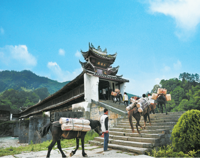
安化县江南镇锡潭村麻溪河上的永锡桥。该桥是安化县规模最大、保存最为完好的木构风雨廊桥。
