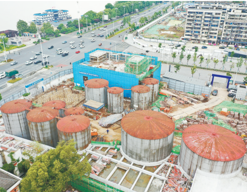
长沙油脂厂项目施工场景。
