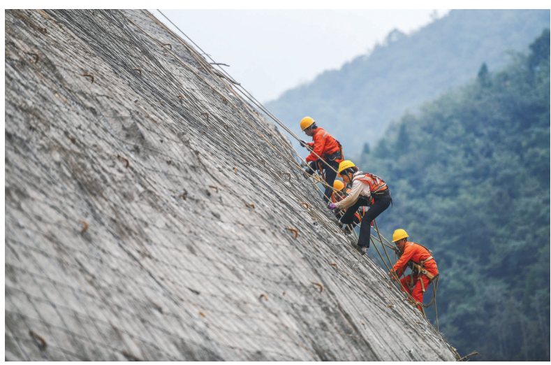
10月9日,工人在道县洪塘瑶族乡湖南紫金锂业有限公司峭壁工地进行生态修复作业。近年来,该县持续实施生态保护修复工程,对破损山体进行生态修复和边坡治理,筑牢生态屏障。蒋克青 廖荣 摄影报道(湖南图片库)
