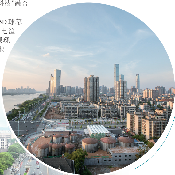
油脂厂改造项目。
