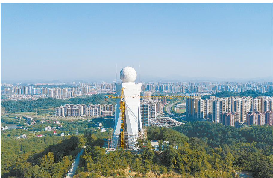
9月23日,建设中的娄底市新一代天气雷达站项目。娄底市新一代天气雷达站是监测台风、暴雨、龙卷风等灾害性天气的主要工具,雷达塔楼高43.3米,建成后将提升灾害性天气的精细化监测和预警预报能力。 吴永华 摄(湖南图片库)
