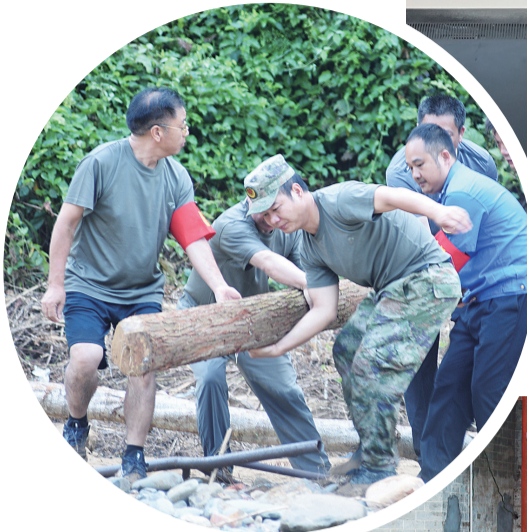
↑8月8日，资兴市黄草镇雷公山村，党员群众一道搭建应急便民桥，为灾后恢复生产、群众出行提供保障。黄春涛 摄
