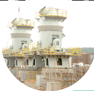
3月20日,临武县安能赣锋碳酸锂项目正在加速推进。 欧阳常海 摄
