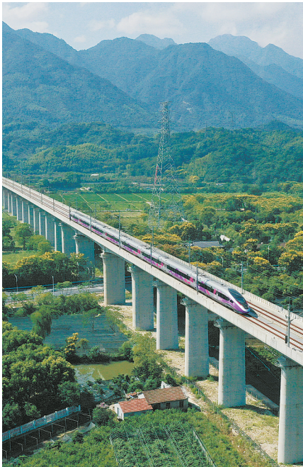
9月6日，杭温（杭州—义乌—温州）高铁正式开通运营，长三角区域路网进一步得到完善。杭温高铁正线全长276公里，设计时速350公里。 图为当日，G9505次高铁列车行驶在杭州市桐庐县境内的杭温高铁跨杭黄铁路特大桥上（无人机照片）。
