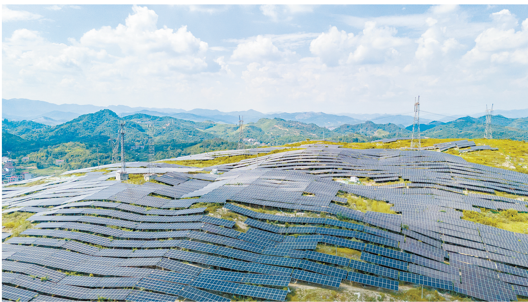
8月27日,涟源市龙塘镇莲花村农光互补光伏发电站,在蓝天白云的映衬下,蔚为壮观。近年,涟源市充分利用石漠化区域建设光伏发电站,有序推进光伏、风电项目建设,实现一山多用,大力发展清洁能源。
