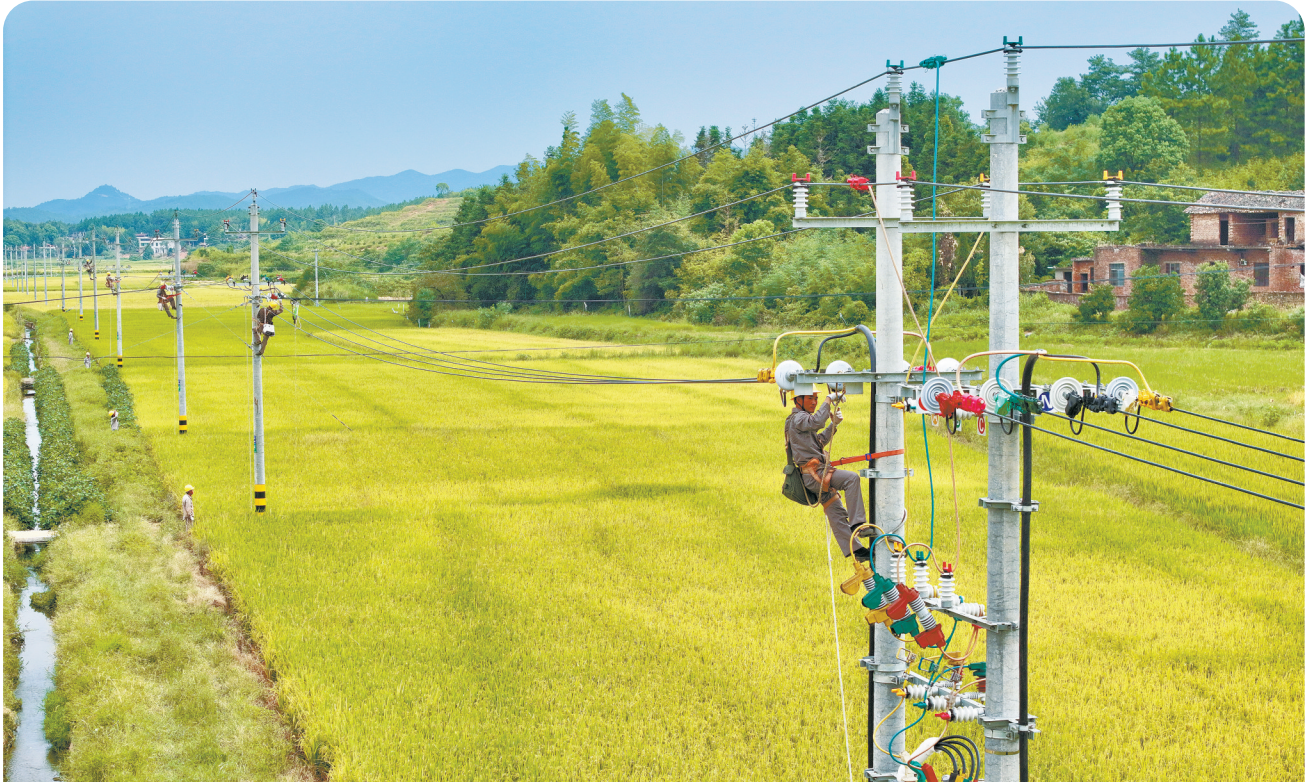
战高温 保供电 8月11日，电力工人顶着烈日在衡南县宝盖镇10kV宝樟Ⅱ线小泉支线进行消缺工作。当天，国网衡南县供电公司组织工作人员对宝盖镇小泉村泉山烟变示范台区进行消缺整改，确保该示范台区在迎峰度夏期间安全可靠供电。 周文曹 曹超 摄影报道(湖南图片库)
