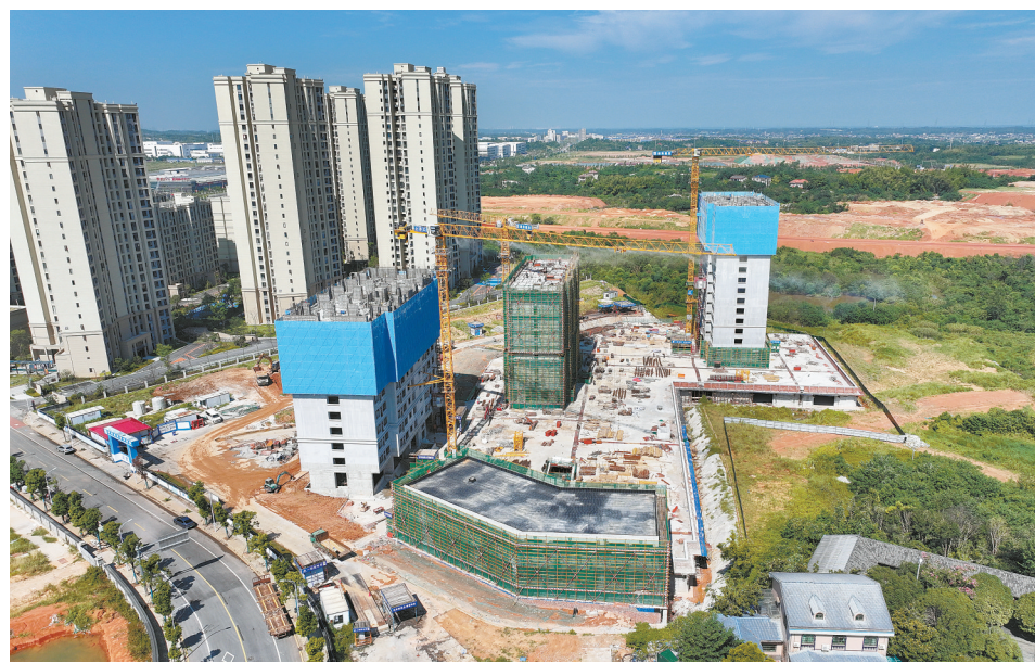
8月6日，航拍湖南建投建工集团直属一公司承建的望城经开区保障性租赁住房一期项目工地。该项目是望城经开区投资1.5亿元建设的人才公寓项目，设计精装修租赁住房657户，可满足附近5G智能终端产业园、手机配件产业园等企业2000余名员工的安居需求。 湖南日报全媒体记者 赵持 通讯员 徐睿 周芳 摄影报道
