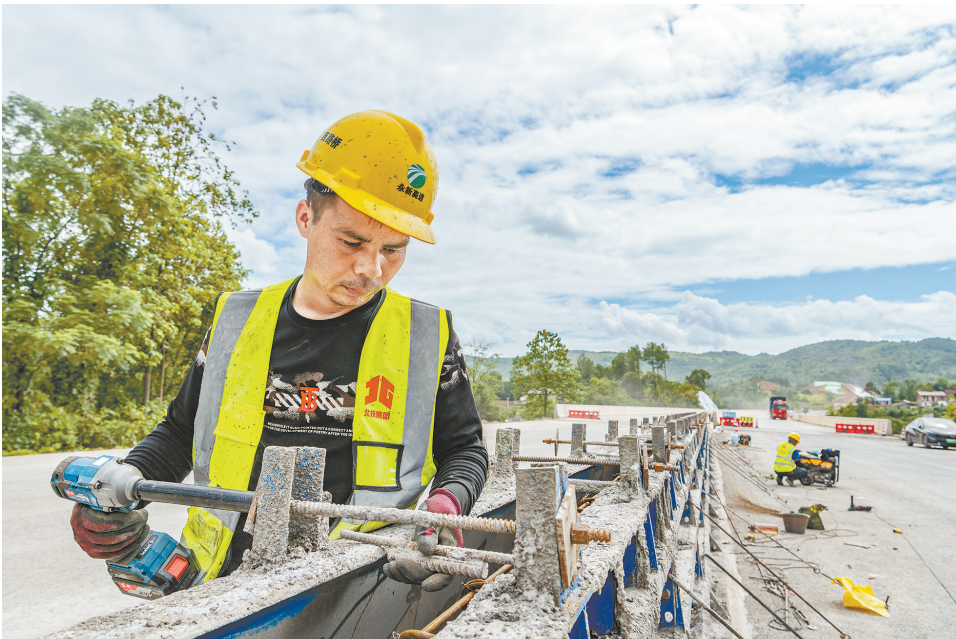
7月30日,东安县白牙市镇,永(州)新(宁)高速公路施工现场,建设者忙着施工作业。目前,该项目已进入路面基层施工收尾阶段,预计年底竣工交付使用。 蔡小平 米家铭 摄影报道(湖南图片库)
