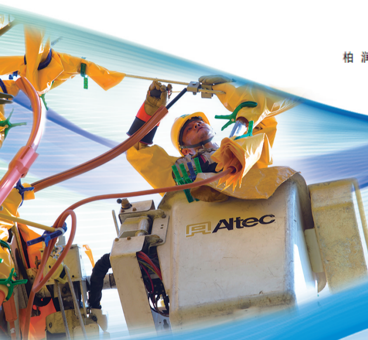
开展带电作业保障迎峰度夏可靠供电。
