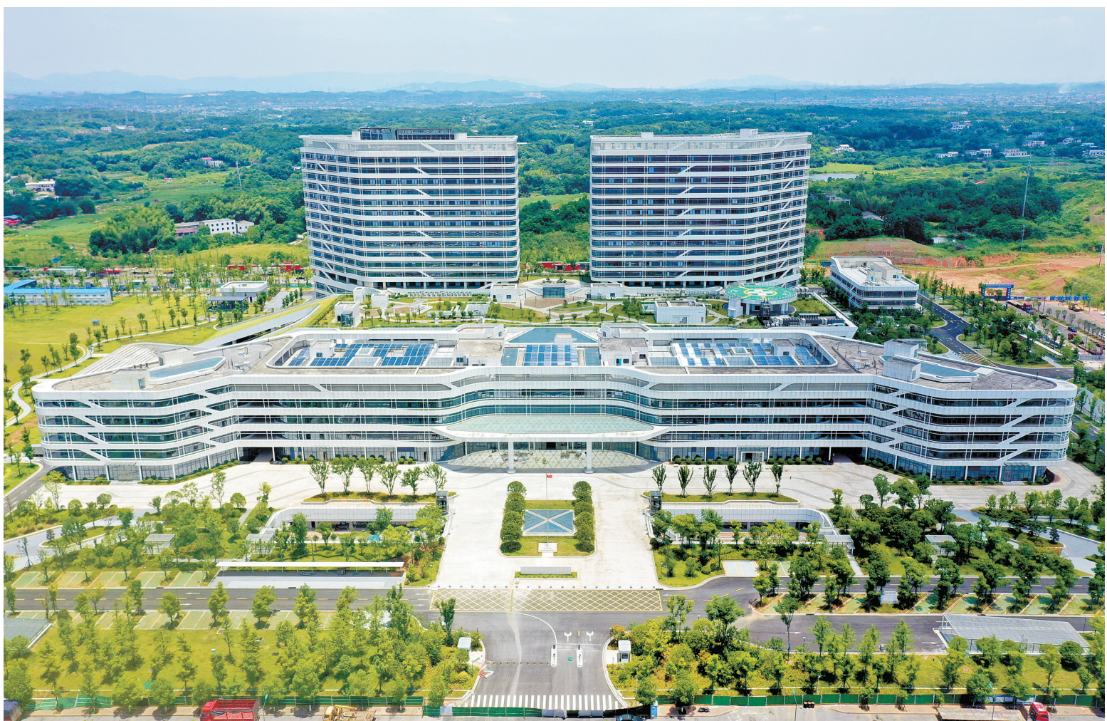
7月15日,由中建三局承建的长沙县人民医院(湖南省人民医院星沙院区)项目主体装饰及机电工程、室外及公共配套工程、医疗专项工程等已竣工验收或收尾,正在进行设备安装调试、智能化建设等工作。该项目位于长沙县星沙松雅湖湿地公园之滨,是该县迄今为止单体投资最大的医院,预计9月底可正式对外开诊运营,届时将进一步提升区域医疗服务水平。 湖南日报全媒体记者 田超 摄
