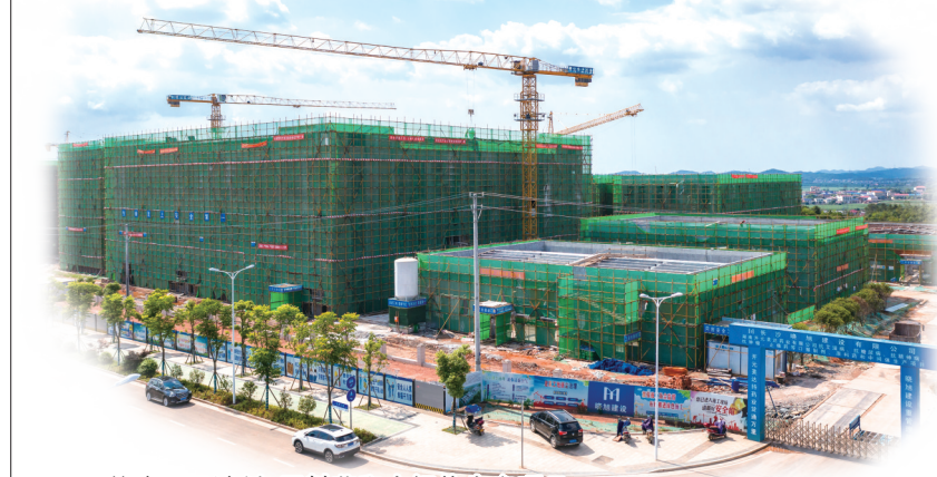
开元美达口服制剂、原料药和中间体生产项目。
