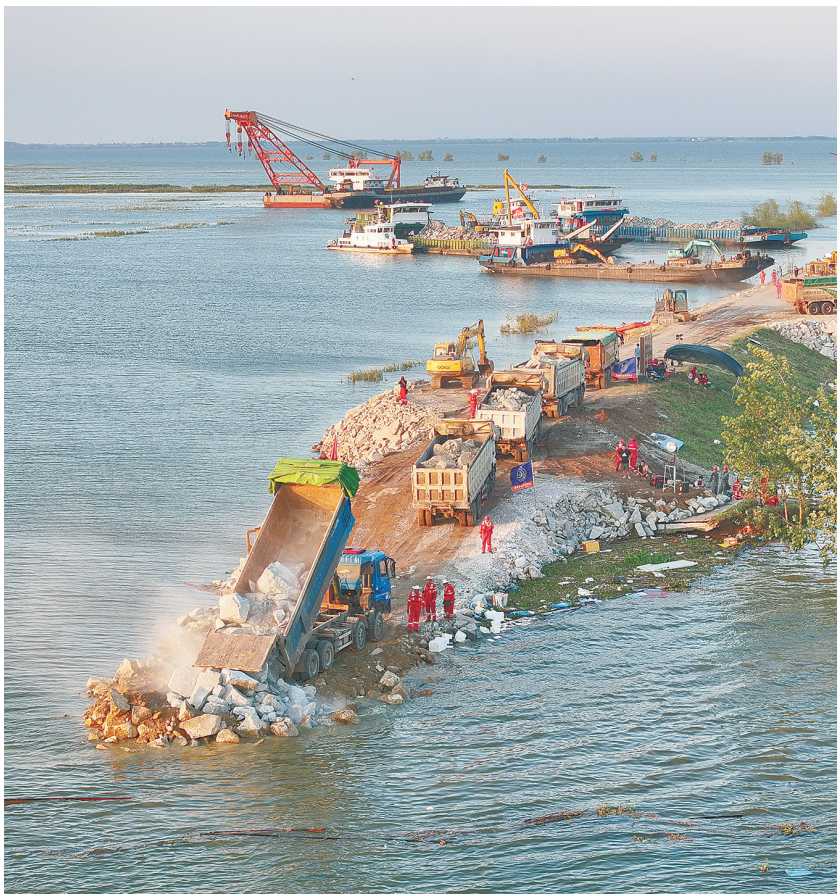
7月7日，华容县团洲垸决口封堵现场，抢险力量正采用船抛石料、双向“进占”、碎石和块石联合填埋等方式，加快封堵进度。
