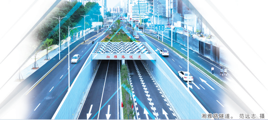
湘雅路隧道。 范远志 摄
