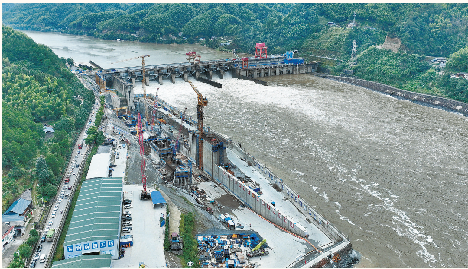
6月27日，湖南航务沅水洪江市至辰溪县航道建设工程二标项目迎来第一次洪峰过境。受持续性强降雨影响，该项目上游多级水电站大坝泄洪。截至当天15时，洪峰以4000立方米/秒的流量经过。奋战在项目建设现场的工程技术人员坚守岗位，在水平面下的围堰内施工作业，确保按质按期完成施工任务。
