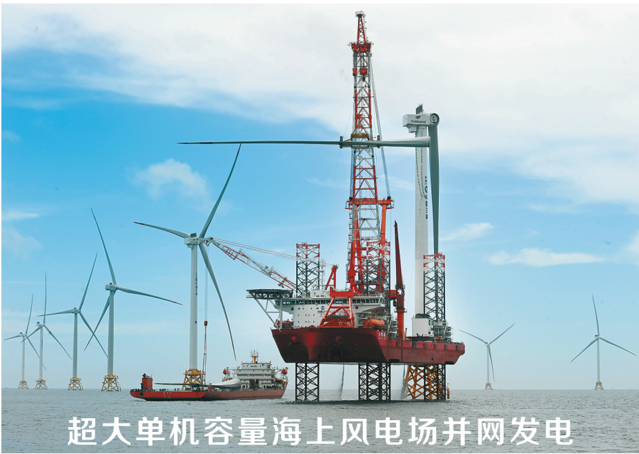
6月27日，三峡集团漳浦二期海上风电项目全容量并网发电，它是我国首个全部采用13兆瓦及以上超大单机容量风机的海上风电场，其中批量化应用了6台16兆瓦海上风电机组。项目位于福建省漳浦县海域，总装机容量400兆瓦。 图为6月19日拍摄的该项目最后一台16兆瓦海上风电机组叶片安装现场。新华社发
