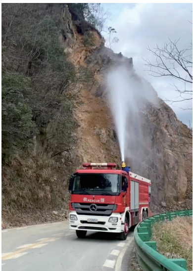
2月19日，消防高压水枪冲击开裂松动的巨石，清除潜在隐患。（炎陵县交通警察大队供图）
