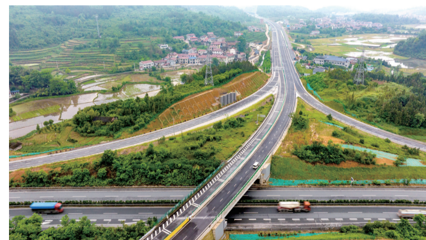
沅辰高速公路辰溪南互通接长芷高速段。
