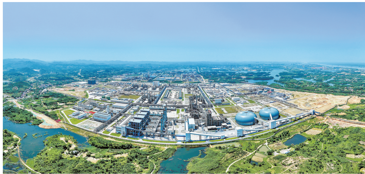
5月14日，中石化湖南石化年产60万吨己内酰胺产业链搬迁与升级转型发展项目新区新貌。作为全球单套产能最大、技术领先的己内酰胺生产研发基地，该项目采用中国石化具有自主知识产权的己内酰胺绿色成套新技术建设，通过产业链升级、产品链延伸、价值链提升，破解“化工围江”“化工围城”，为沿江重化工业绿色转型发展提供新路径、新模式。
