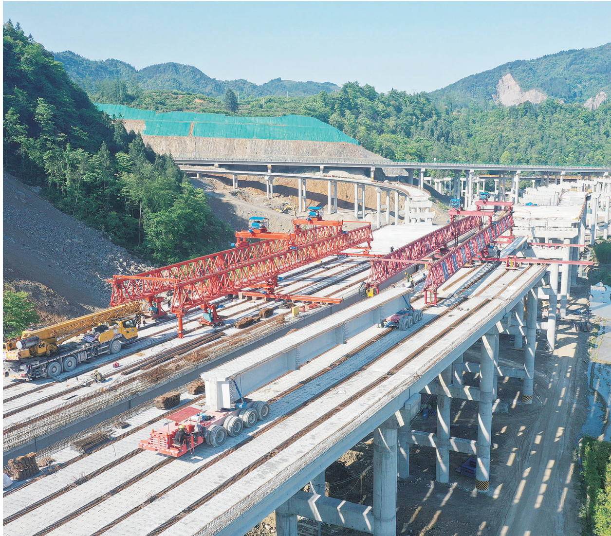
4月28日,桑龙高速龙山县茅坪枢纽(连接到龙吉高速)施工现场一派繁忙景象。桑龙高速公路是我省西北部一条重要的高速大通道,具有承接南北、连接东西的重要作用,东起于桑植西互通,西止于茅坪枢纽,线路全长61.494千米,预计2024年底通车。建成后,对于连通湘鄂渝川省际通道,促进武陵山西部地区发展具有重大意义。
