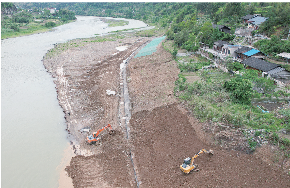
4月24日,碗米坡水库大坝下游保靖县碗米坡镇押马村河段,工人在修筑河堤。入汛以来,该镇组织村民修筑加固河堤,增强河道防洪能力,确保群众生命财产安全。 俞采华 摄(湖南图片库)
