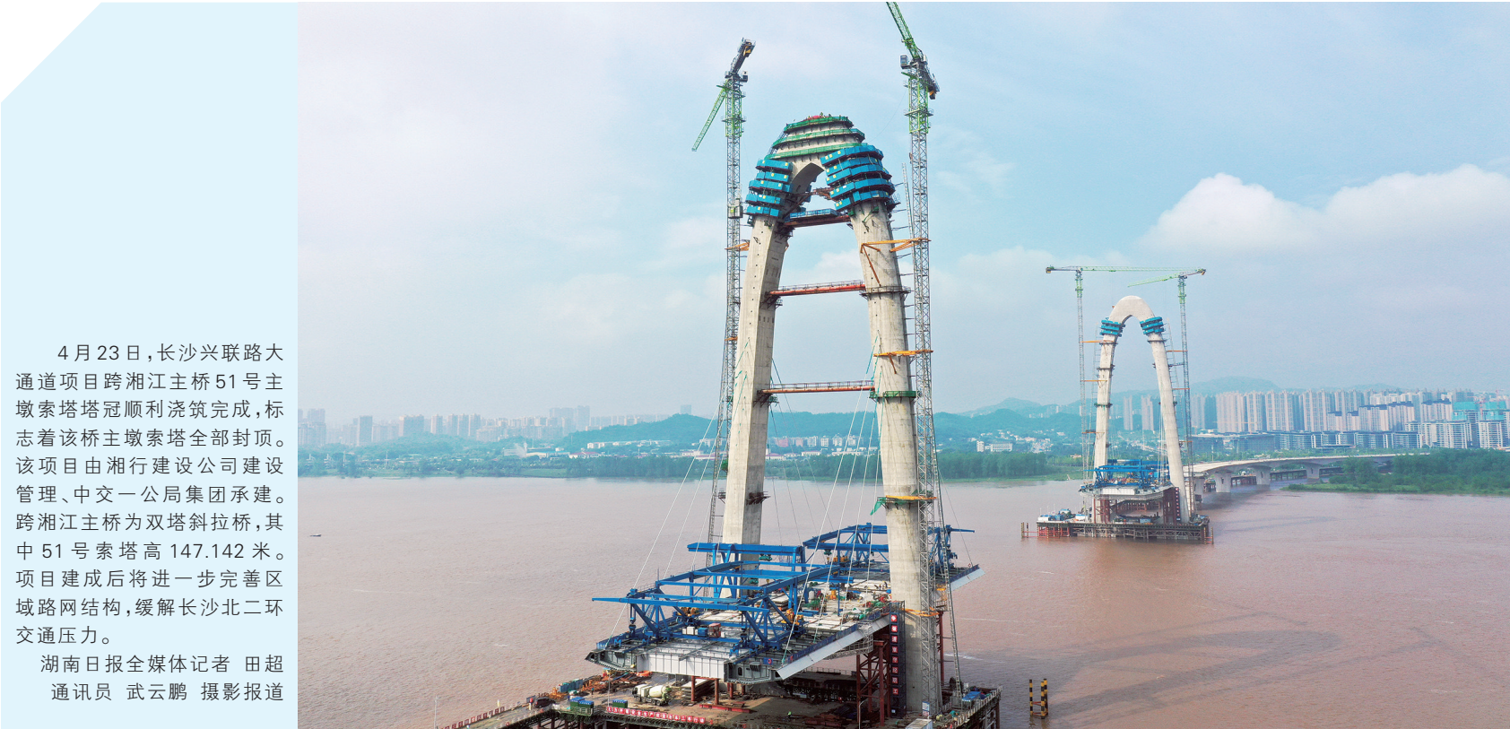
4月23日,长沙兴联路大通道项目跨湘江主桥51号主墩索塔塔冠顺利浇筑完成,标志着该桥主墩索塔全部封顶。该项目由湘行建设公司建设管理、中交一公局集团承建。跨湘江主桥为双塔斜拉桥,其中51号索塔高147.142米。项目建成后将进一步完善区域路网结构,缓解长沙北二环交通压力。
