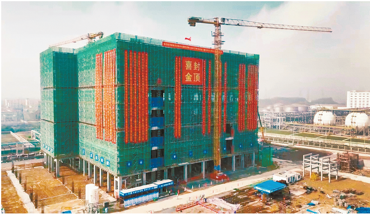
4月18日，岳化新材料45万吨尼龙6聚合项目一期工程主体厂房封顶。采访单位供图
