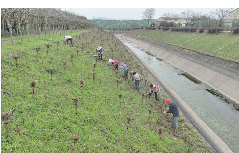
3月27日，永州市零陵区双牌干渠，工人在进行护坡除草草青工作，以保持渠道边坡干净整洁，便于巡渠护渠，查险除险，确保行洪畅通。
