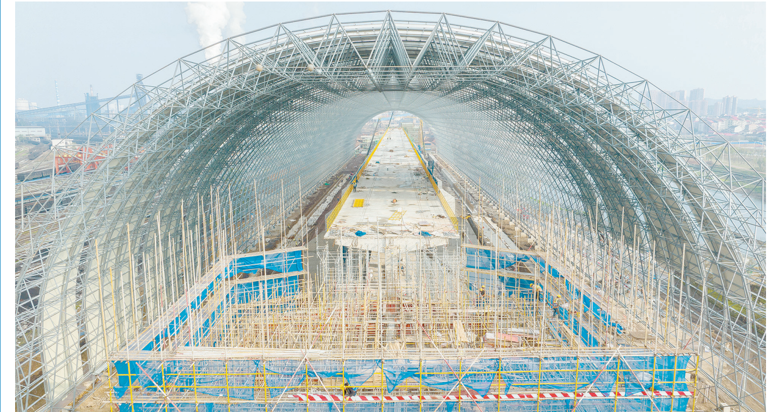
3月26日,娄底市湖南涟源钢铁有限公司涟钢炼铁厂老线综合料场环保转型升级改造项目建设现场。该项目将对现有露天料场及环保设施进行升级改造,实现清洁生产、降本增效。 吴永华 摄(湖南图片库)
