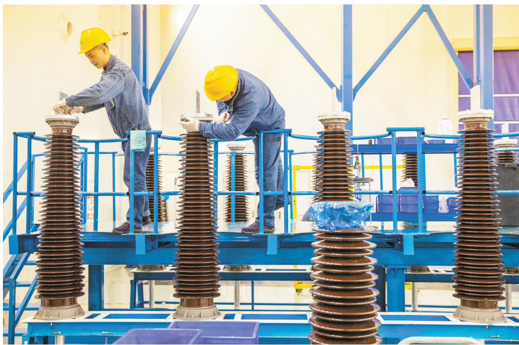
醴陵经开区华鑫电瓷工作人员在安装检测空心瓷绝缘子电瓷产品。(资料照片)
