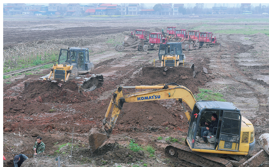
3月16日，南县明山镇丰安坝村，多台工程机械在高标准农田建设项目现场进行土地平整施工。该项目总面积1050亩，预计在本月底完成施工。
