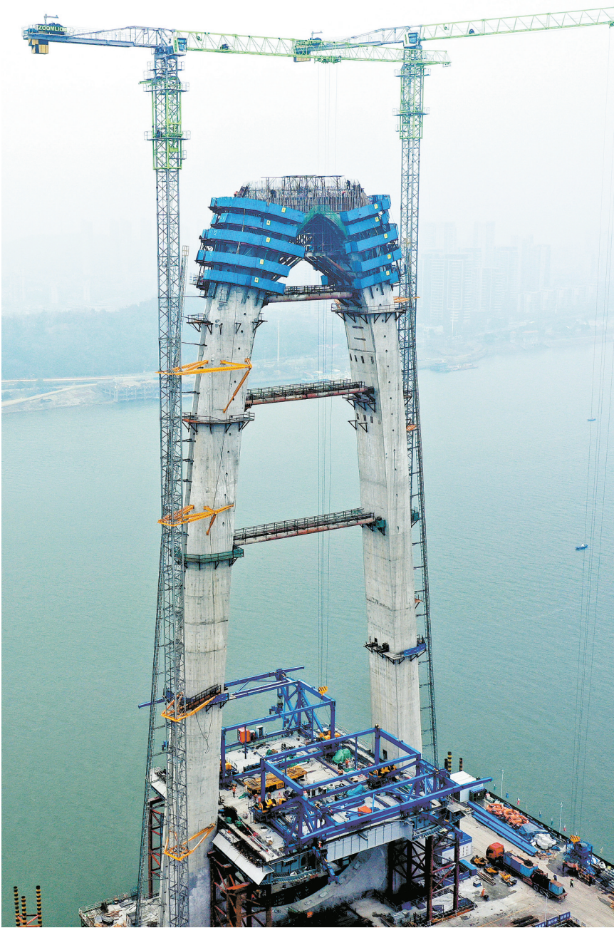
3月6日,长沙兴联路大通道项目跨湘江主桥50号主墩上横梁完成浇筑,标志着项目主桥首个主塔顺利合龙。该项目由长沙建投投资管理、中交一公局集团承建,跨湘江主桥为双塔斜拉桥,主跨380米,是长沙目前在建桥面最宽、单跨最大、桥长最长的过江大桥。预计主桥今年6月实现主塔封顶,力争12月实现通车目标。
