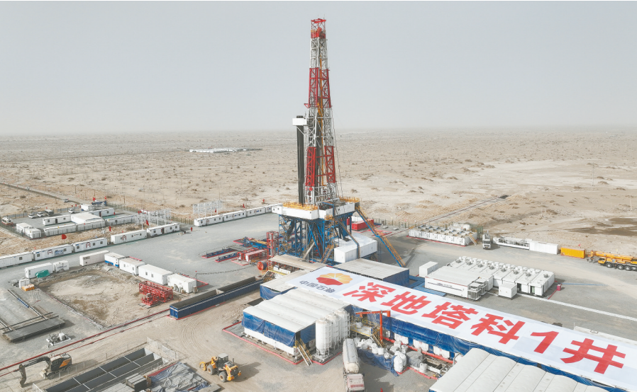
3月4日在新疆塔克拉玛干沙漠拍摄的深地塔科1井（无人机照片）。 新华社 发
